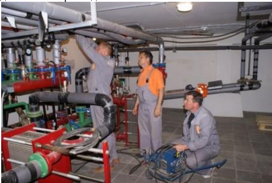
Испытания трубопроводов на герметичность в тепловом пункте
