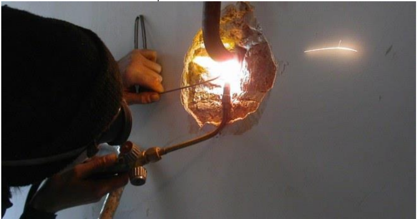
Газовая сварка трубы из нижнего положения
